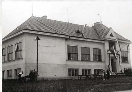
ZÁKLADNÍ ŠKOLA T. G. Masaryka byla otevřena v roce 1930. V budově se nacházely dvě třídy, do kterých chodilo přes sto žáků.
